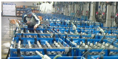
蓄電池の充電工程
