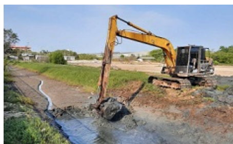
河川の浚渫工事 (SGS)
